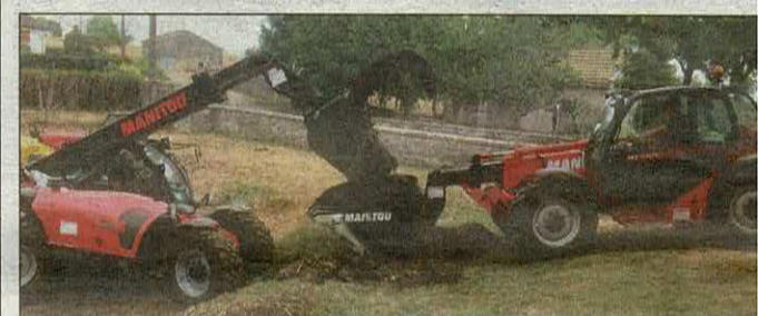
Des engins de toutes sortes ont été nécessaires pour ces travaux.
